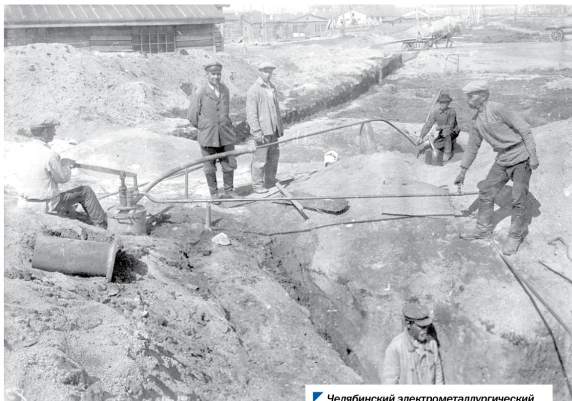
Челябинский электрометаллургический комбинат. Опрессовка водопровода, 1933 г.
